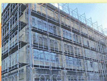
旧野津高校解体用足場工事
