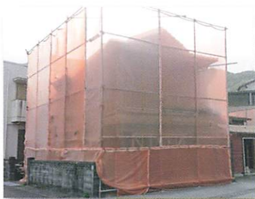
佐伯市海崎 T 様邸解体工事
