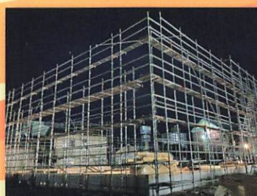
佐伯店舗新築用足場工事
