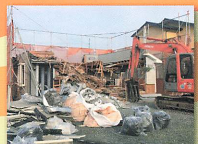
三重町 U 様邸解体工事
