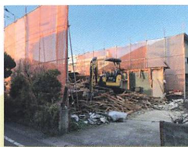
中津市 K 様邸解体工事
